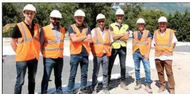
La direction de Serpol en visite sur le chantier de la station d'épuration avec le maire Patrick Chalamet. LeDL/M.-C.B.
