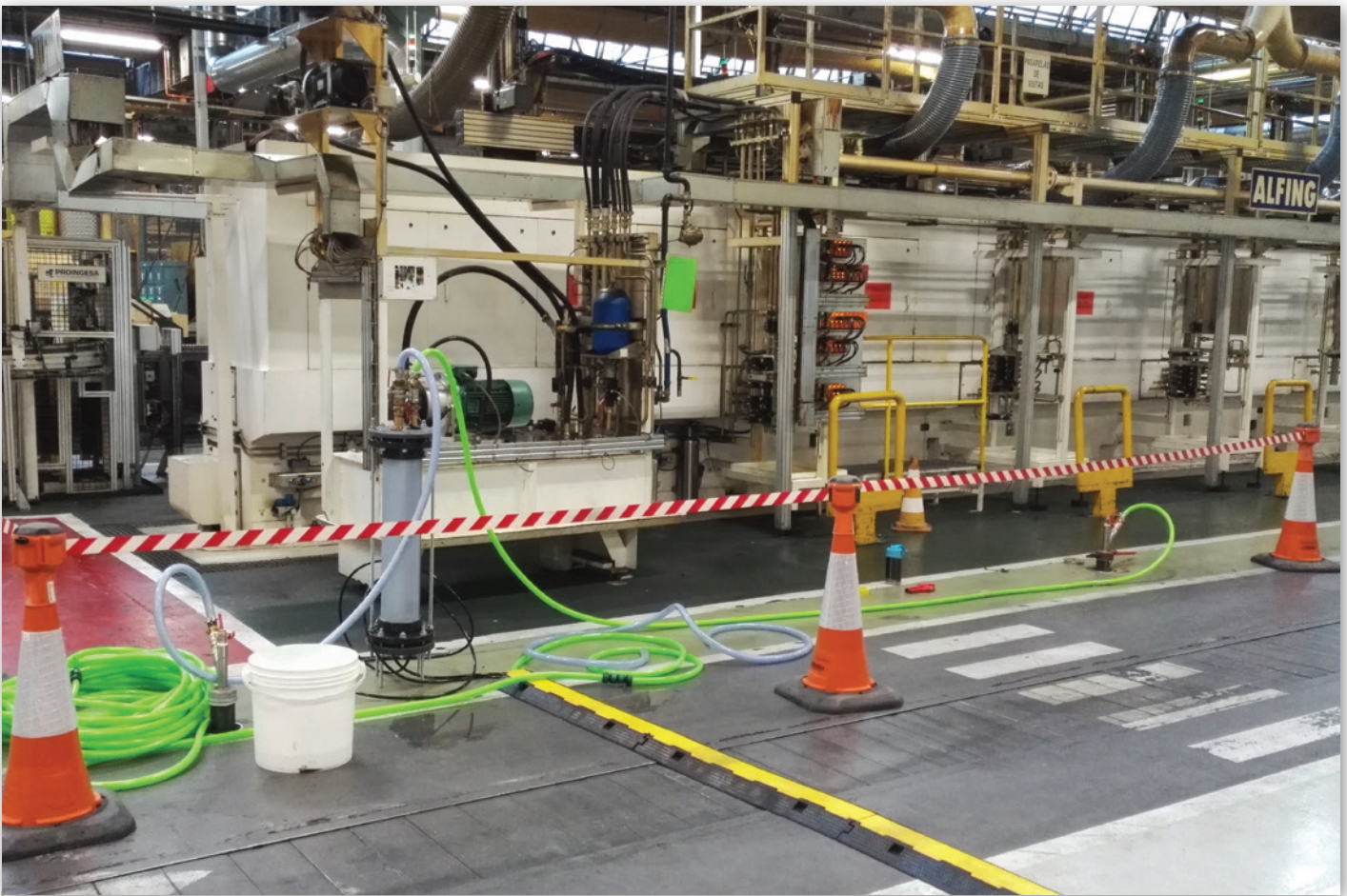
Mousseur installé sur le site pilote et en phase d'injection de mousse de blocage.
